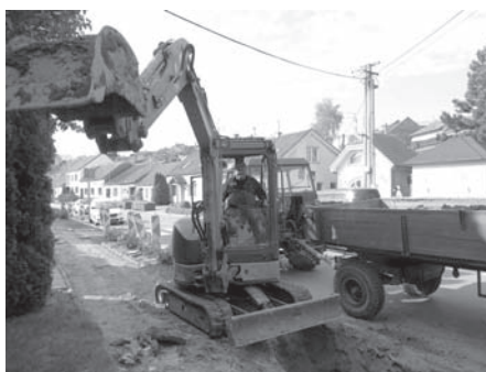
Oprava vodovodu a chodníku v ulici pod Břehy.
