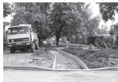
Budování úseku chodníku za benzínovou pumpou na ulici Nádražní.
