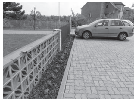
Nová parkovací plocha u hlavního vstupu do MŠ.
