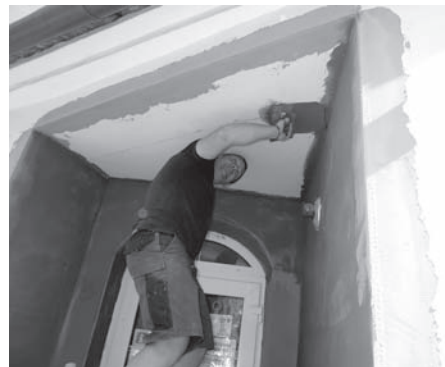
Po ložských rozsáhlých opravách interiérů knihovny a TIC přišla nyní na řadu i venkovní fasáda.
