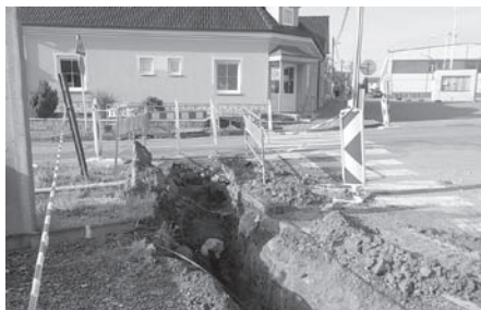
Oprava vodovodu, křižovatka ulic V Sadech a Hodonínská.
