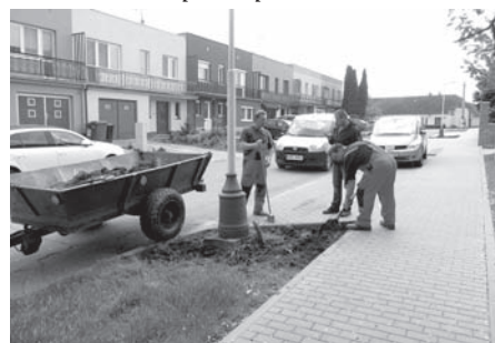
Terénní úpravy v předzahrádkách v ulici V Sadech.
